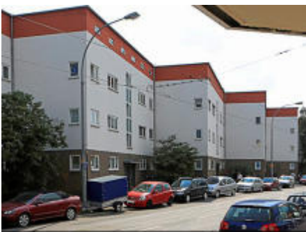
Die sägezahnartige Anordnung der Häuser hat die Siedlung in der Bruchfeldstraße im Volksmund den Namen Zickzackhausen eingebracht. Fotos (2): Christes
