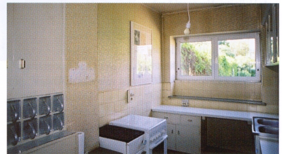
Abb. 3: „Frankfurter Küche“ im ernst-may-haus vor der Restaurierung
